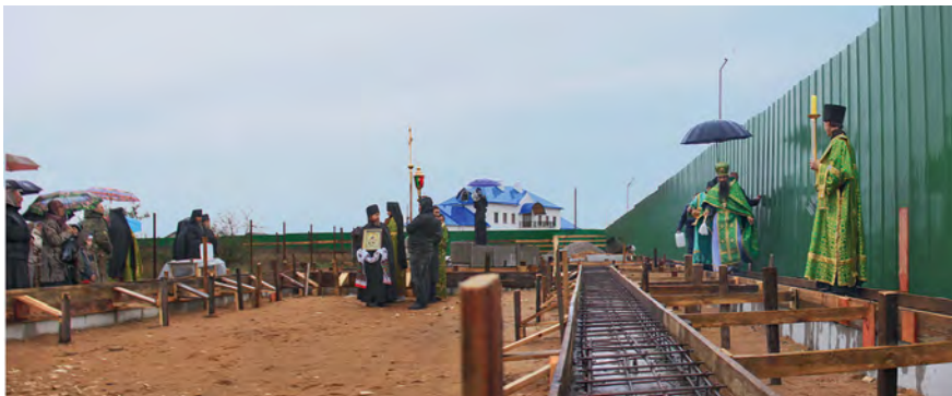
Освящение фундамента здания будущего музея 8 октября 2012 г.
