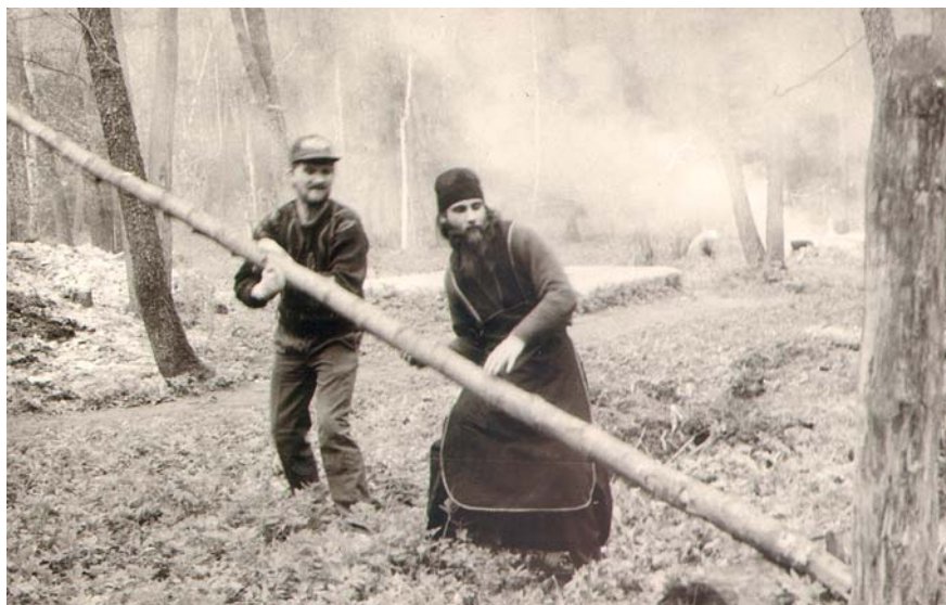
Работы по подготовке территории на Святом источнике, 1992 г.
